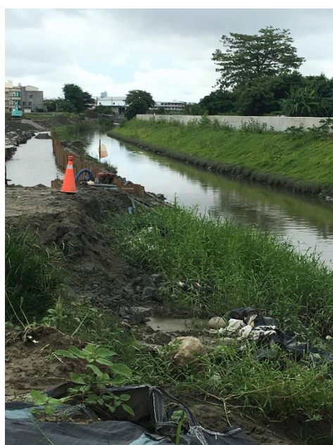
圖 2-2:堤防正在施工
