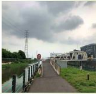
河道中繼站(單車橋)
