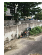
圖3-1水泥原色的河堤可能增加美化
